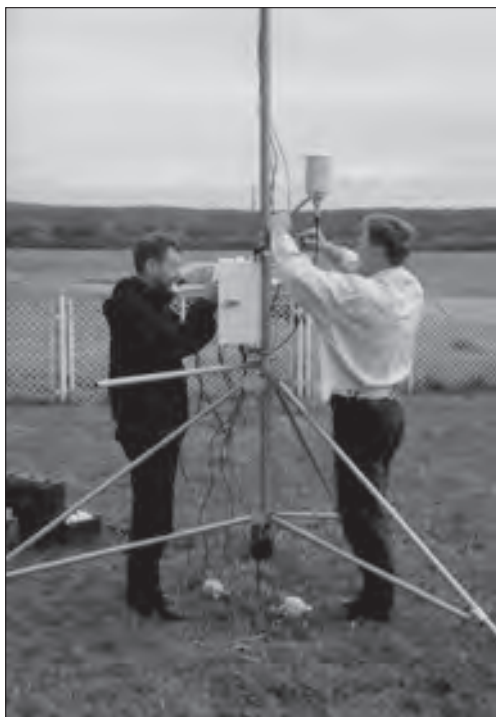
Fot. 1. Instalacja stacji terenowej w Katowicach–Muchowiec (21.09.1999)
